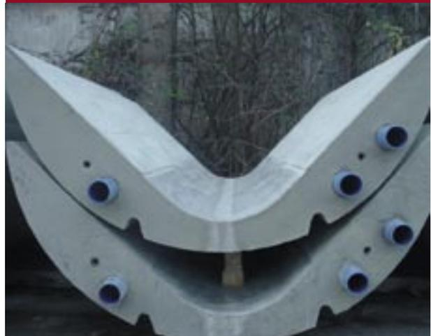
Auf Schienen wurden die vorgefertigten Trockenwetterrinnen mit integriertem Wärmetauscher in den Abwasserkanal eingeschoben.
