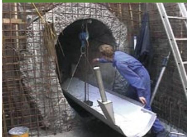
Einbringen eines Wärmetauscher-Elementes in einen bestehenden Kanal.
