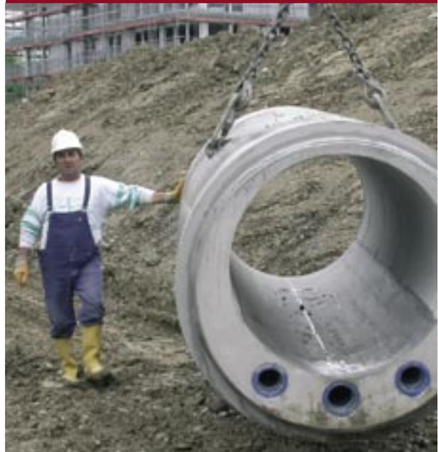
Die rationelle Installation von Kanalwärmetauschern mit vorgefertigten Kanalwärmetauscher-Elementen senkt die Investitionen.
